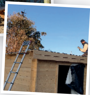
Bâtiment en bois pour le rangement à l'école
